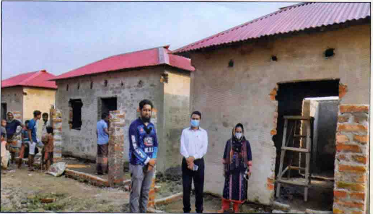
গৃহহীনদের জন্য নির্মিত ঘর পরিদর্শন
