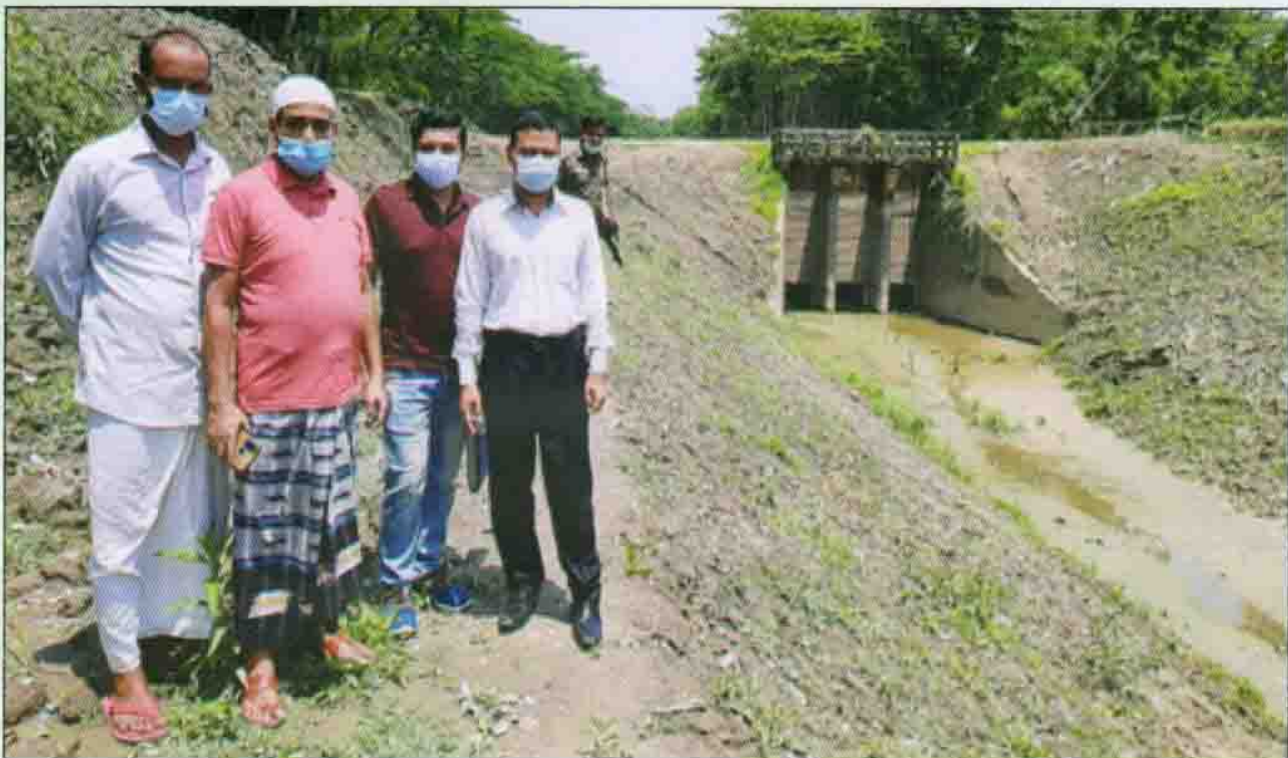
করতি খাল খনন ও স্লুইচ গেট পরিদর্শন
