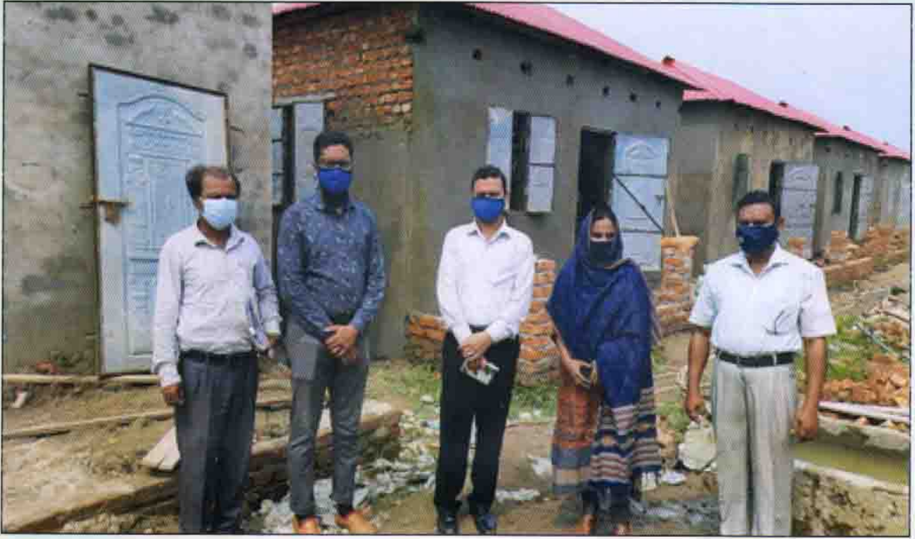
গৃহহীনদের জন্য নির্মিত ঘর পরিদর্শন
