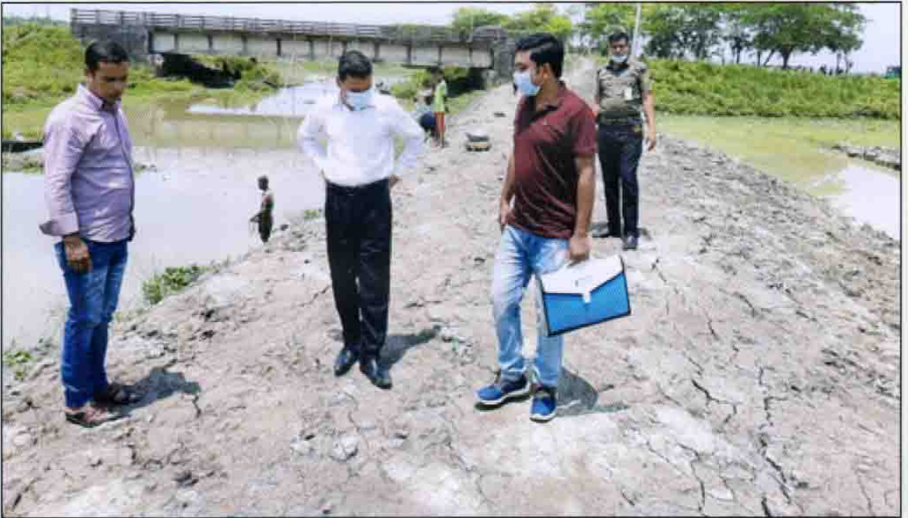
পানি উন্নয়ন বোর্ড এর বাধ নির্মাণ কাজ পরিদর্শন
