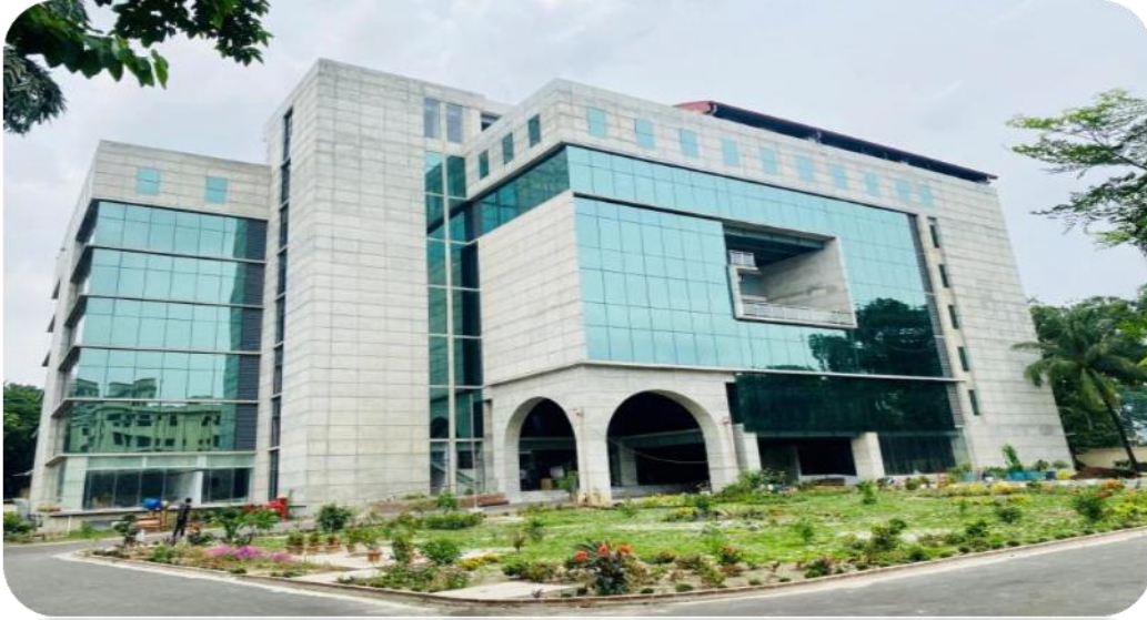
কেমিক্যাল মেট্রোলজি অবকাঠামো সমৃদ্ধকরণ প্রকল্পের নবনির্মিত ভবন
