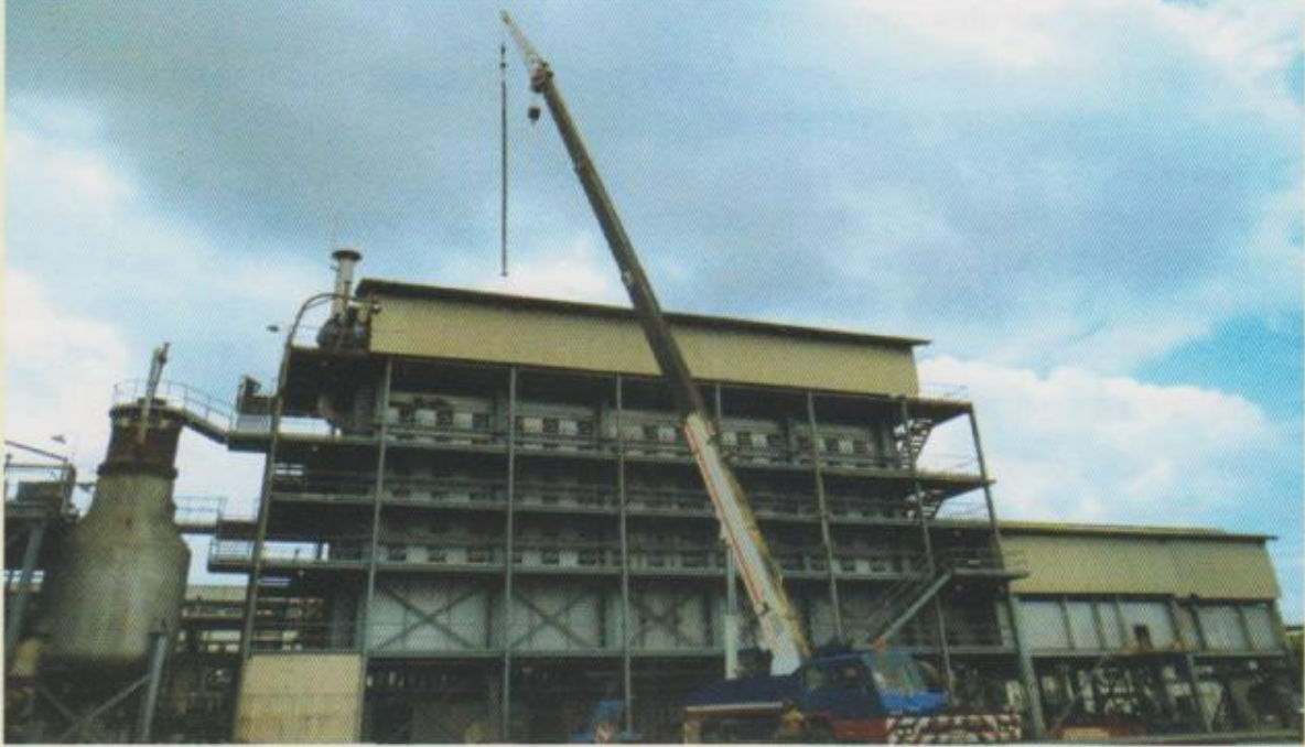
চিত্র : প্রাইমারী রিফরমারের টিউব পরিবর্তন
