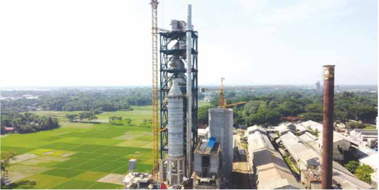
ছাতক সিমেন্ট প্রকল্পে স্থাপিত সিমেন্ট তৈরির প্রি-হিটার
