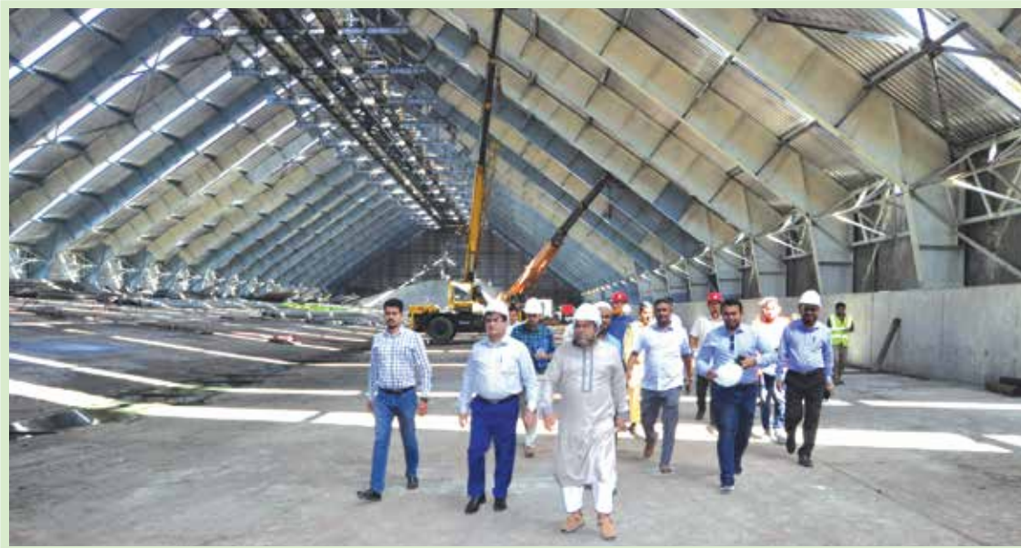
সিইউএফএল ইউরিয়া বাক্স গোডাউনের মেরামত কার্যক্রম পরিদর্শন
