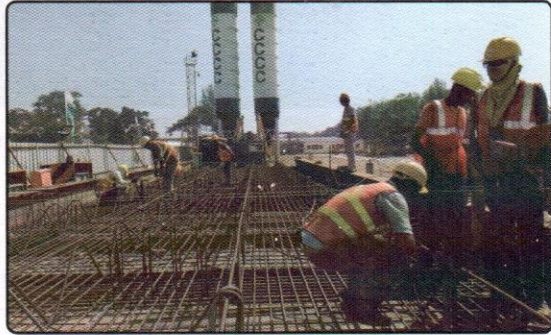
গাইড ওয়াল নির্মাণ কাজের চিত্র
