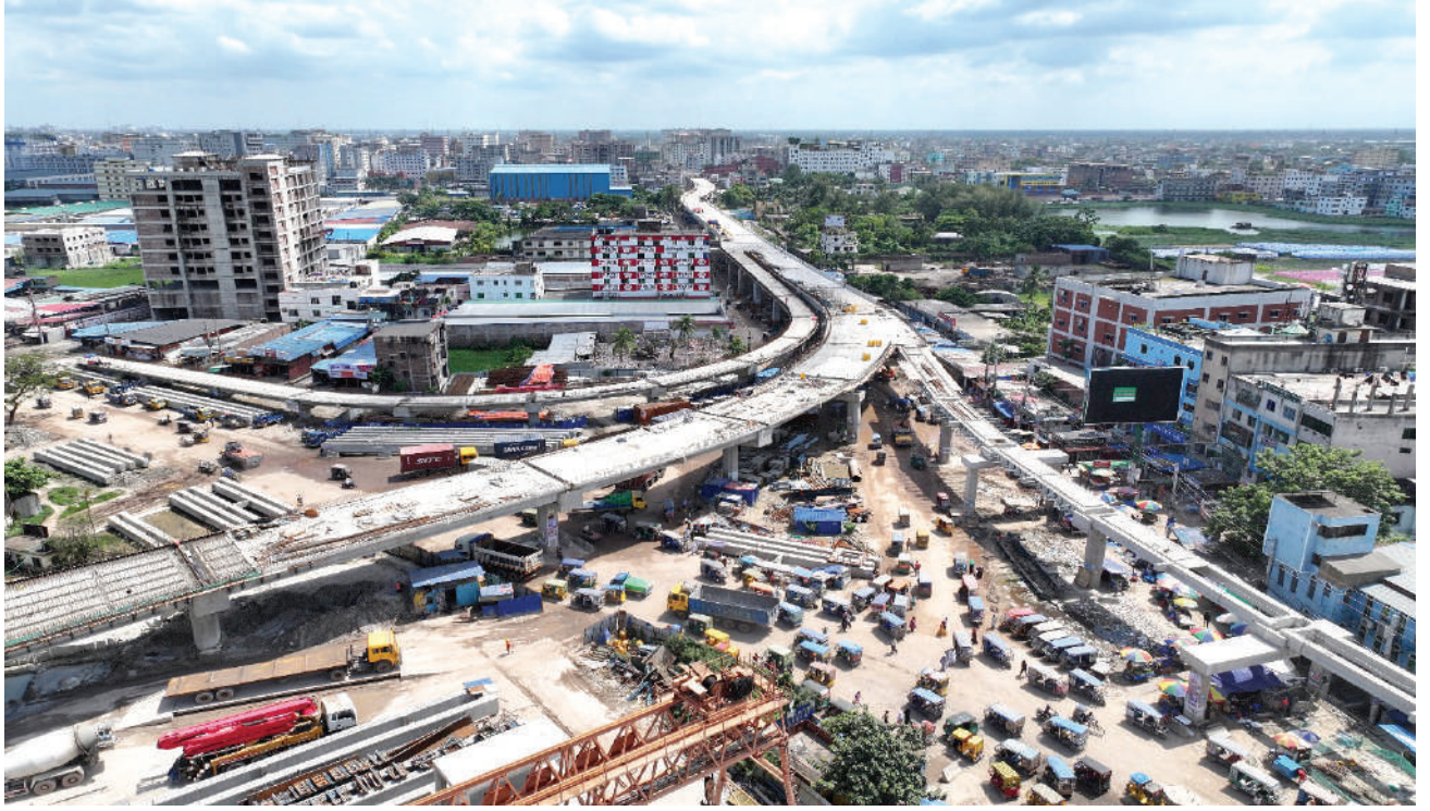
পঞ্চবটি হতে মুক্তারপুর সেতু পর্যন্ত সড়ক প্রশস্তকরণ ও দোতলা রাস্তা নির্মাণ প্রকল্পের ভৌত কাজ
