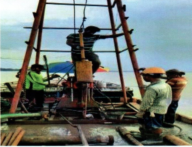
চিত্র: বেতাগী-পটুয়াখালী সড়কে পায়রা নদীর উপর সেতু নির্মাণ প্রকল্পের চলমান সাব-সয়েল ইনভেস্টিগেশন কার্যক্রম
