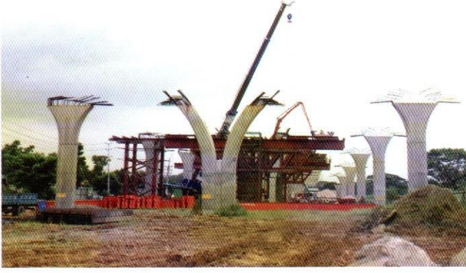
ঢাকা এলিভেটেড এক্সপ্রেসওয়ে পিপিপি প্রকল্পের নির্মিত কলাম
