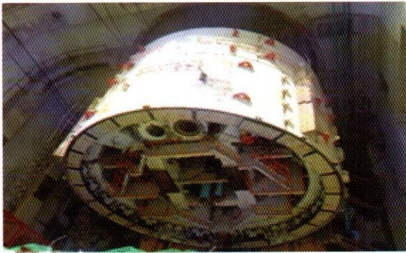
চলছে Tunnel Boring Machine (TBM) Assembling এর কার্যক্রম
