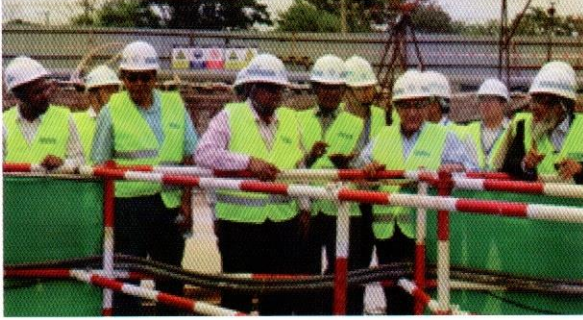
কর্ণফুলী টানেল নির্মাণ প্রকল্পের কার্যক্রম পরিদর্শন করছেন POE এর সদস্যগণ
