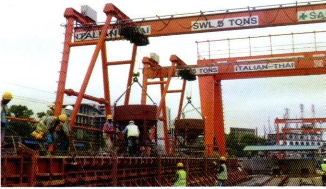
ঢাকা এলিভেটেড এক্সপ্রেসওয়ে পিপিপি প্রকল্পের চলমান আই গার্ডারের নির্মাণ কাজ
