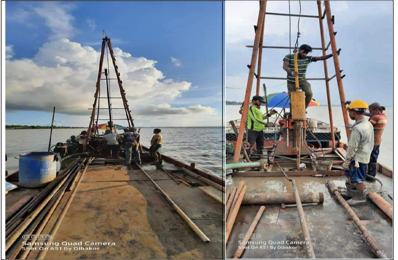
চিত্র-৩৬: কচুয়া-বেতাগী-পটুয়াখালী-লোহালিয়া-কলাইয়া সড়কে পায়রা নদীর উপর সেতু নির্মাণ প্রকল্পের মাটি পরীক্ষা কার্যক্রম
