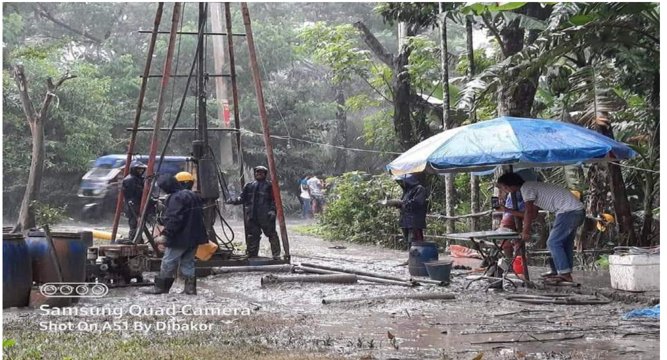
চিত্র-৩৭: কচুয়া-বেতাগী-পটুয়াখালী-লোহালিয়া-কলাইয়া সড়কে পায়রা নদীর উপর সেতু নির্মাণ প্রকল্পের মাটি পরীক্ষা কার্যক্রম
