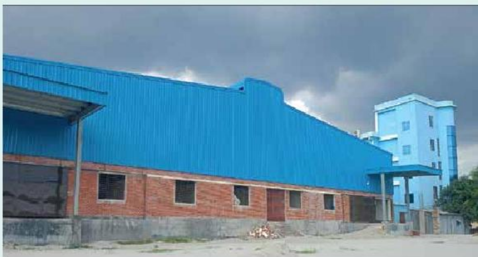
ঢাকা জেলার গাবতলীতে নির্মিত Vapour Heat Treatment Plant
