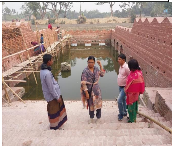
পুঠিয়া জাদুঘর এলাকায় রানির ঘাটে চলমান মেরামত কাজ পরিদর্শন
