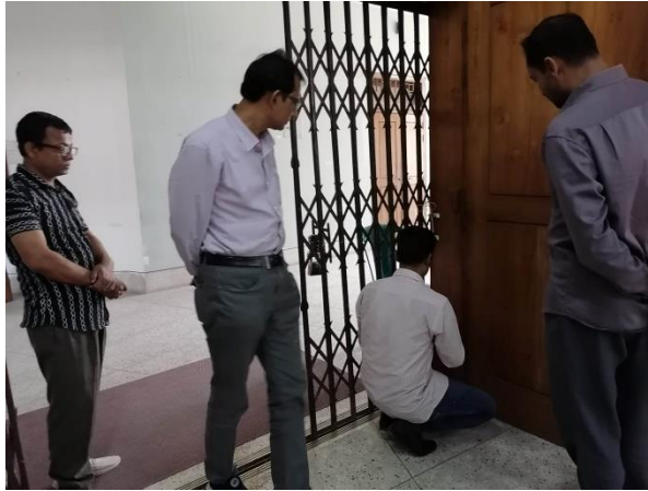
ডিভাইস স্থাপন কার্যক্রম
