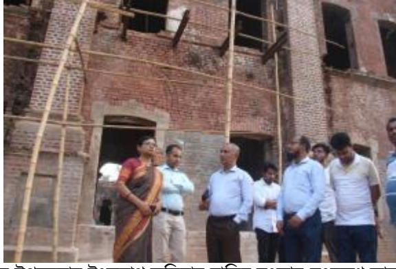
ঠাকুরগাঁও জেলার রাণীশংকৈল উপজেলার টংকনাথ জমিদার বাড়ির সংস্কার-সংরক্ষণ কাজ পর্যবেক্ষণ করেন জনাব মোঃ আতাউর রহমান, যুগ্মসচিব, সংস্কৃতি বিষয়ক মন্ত্রণালয় মহোদয়
