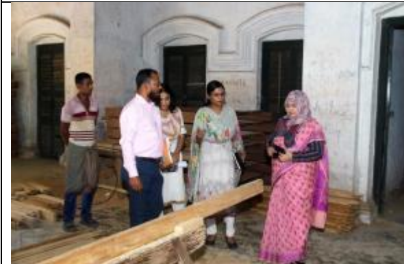
জনাব সাবিনা আলম, মহাপরিচালক (অতিরিক্ত সচিব) নাটোর রাজবাড়িস্থ বৈঠকখানার চলমান সংস্কার-সংরক্ষণ কাজ পরিদর্শন করেন।
