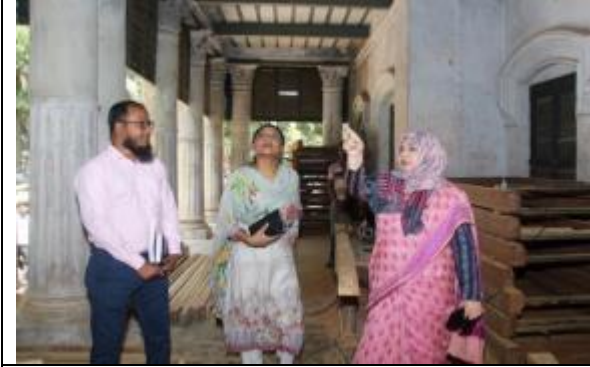
জনাব সাবিনা আলম, মহাপরিচালক (অতিরিক্ত সচিব) নাটোর রাজবাড়িস্থ বৈঠকখানার চলমান সংস্কার-সংরক্ষণ কাজ পরিদর্শন করেন।
