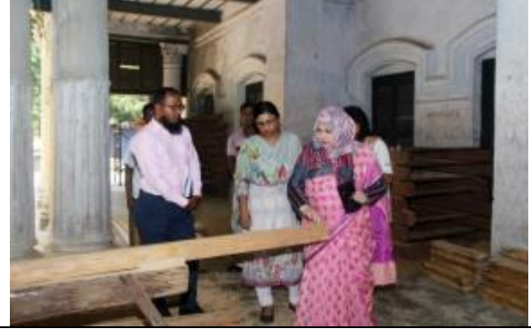
জনাব সাবিনা আলম, মহাপরিচালক (অতিরিক্ত সচিব) নাটোর রাজবাড়িস্থ বৈঠকখানার চলমান সংস্কার-সংরক্ষণ কাজ পরিদর্শন করেন।
