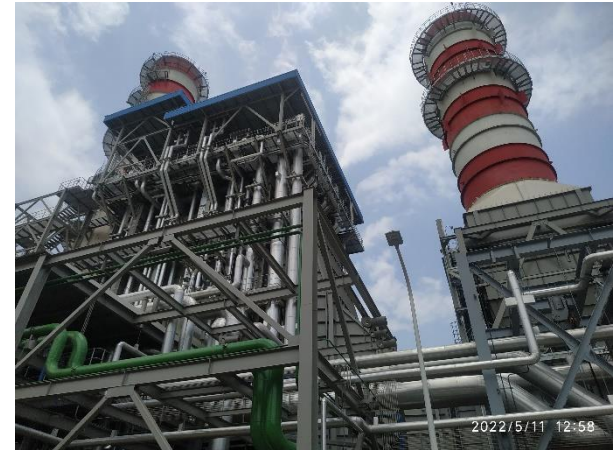
Fig. 1.2.3: Superstructure construction of HRSG and exhaust stack
