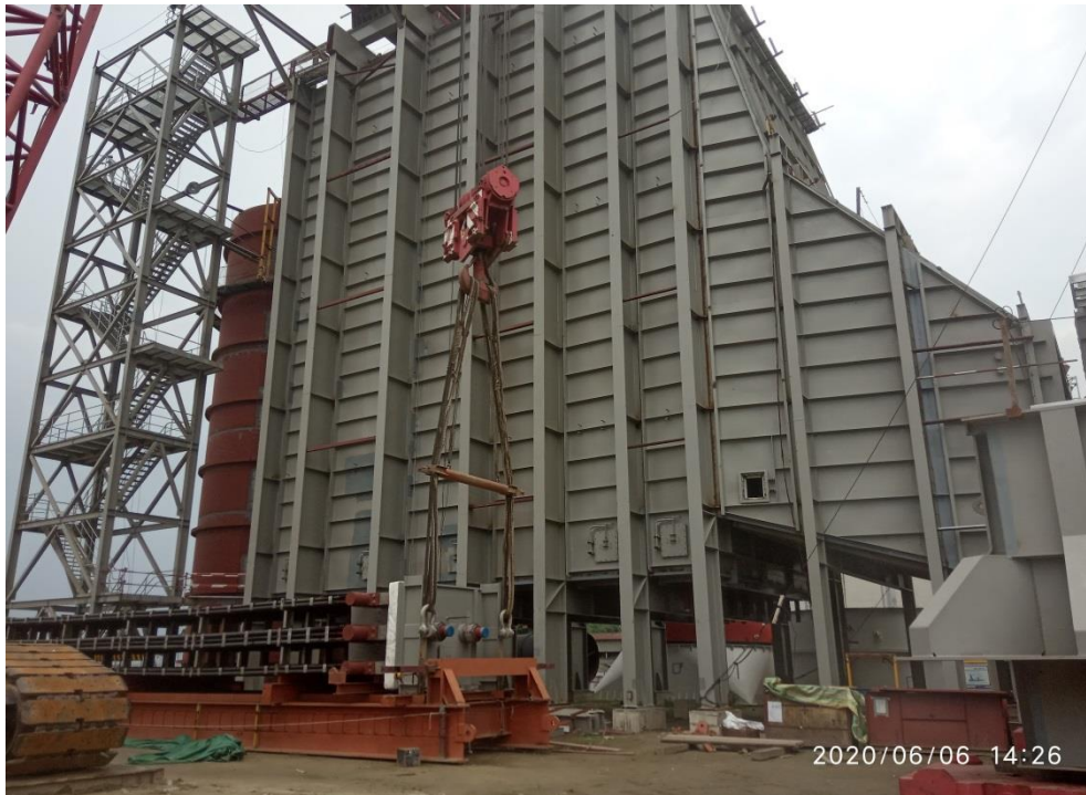
Fig: Photograph of Superstructure Construction of HRSG and Exhaust Stack
