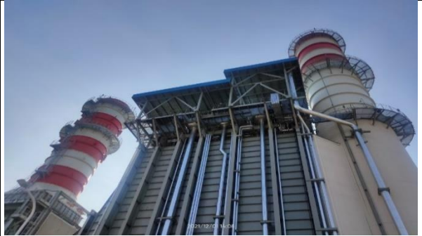
Construction of HRSG and Exhaust Stack
