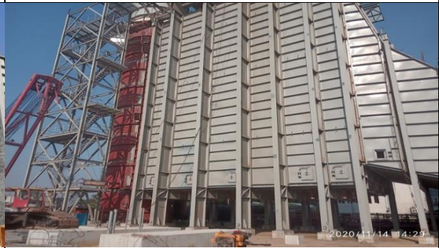
Construction of HRSG and Exhaust Stack
