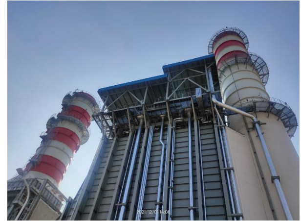
Fig. 1.2.3: Superstructure Construction of HRSG and Exhaust Stack
