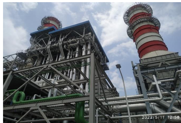
Fig. 1.2.3: Superstructure construction of HRSG and exhaust stack
