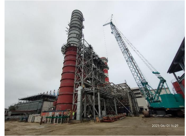
Superstructure Construction of HRSG and Exhaust Stack
