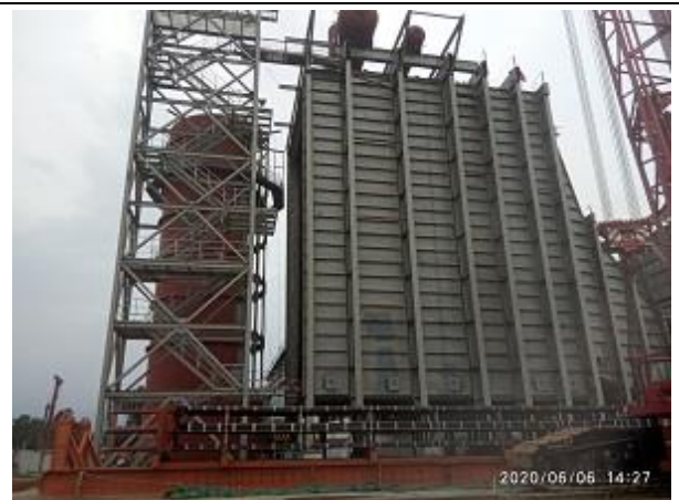
Fig: Superstructure Construction of HRSG and Exhaust Stack
