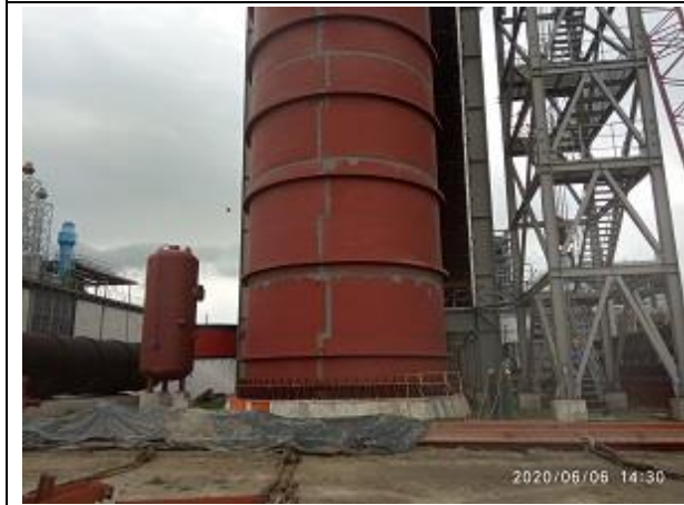
Fig: HRSG blown cooling water pool
